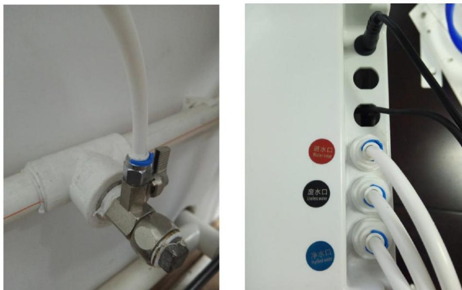
7. В соответствии с расстоянием отрежьте нужное количество трубы, чтобы присоединить один конец к порту отработанной воды, отмеченный черным, а другой конец присоединить к коммуникациям, чтобы удалять отработанную воду, которая появляется во время
